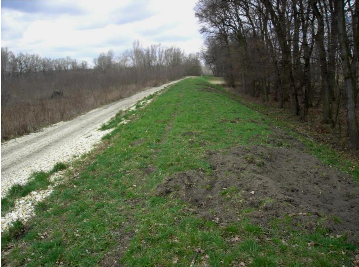
Schäden durch Schwarzwild auf Dämmen und Böschungsflächen sind zu sanieren
