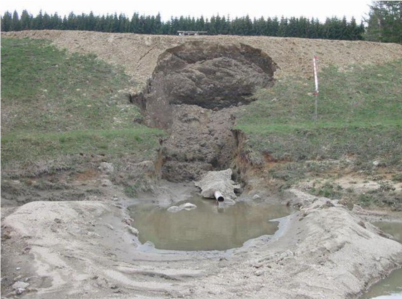
Bei Materialwechsel (Rohre, Schachtwände, Widerlager kann es bei wiederholter Beaufschlagung zu Materialaustrag kommen und letztlich zum Versagen der Anlage
