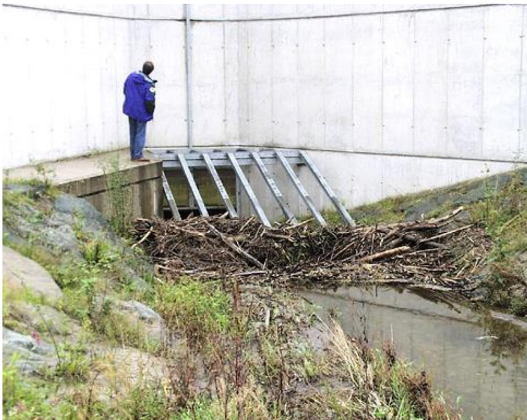
Verklausungen bei Retentionsanlagen sind unmittelbar nach der Anlagentleerung zu entfernen
