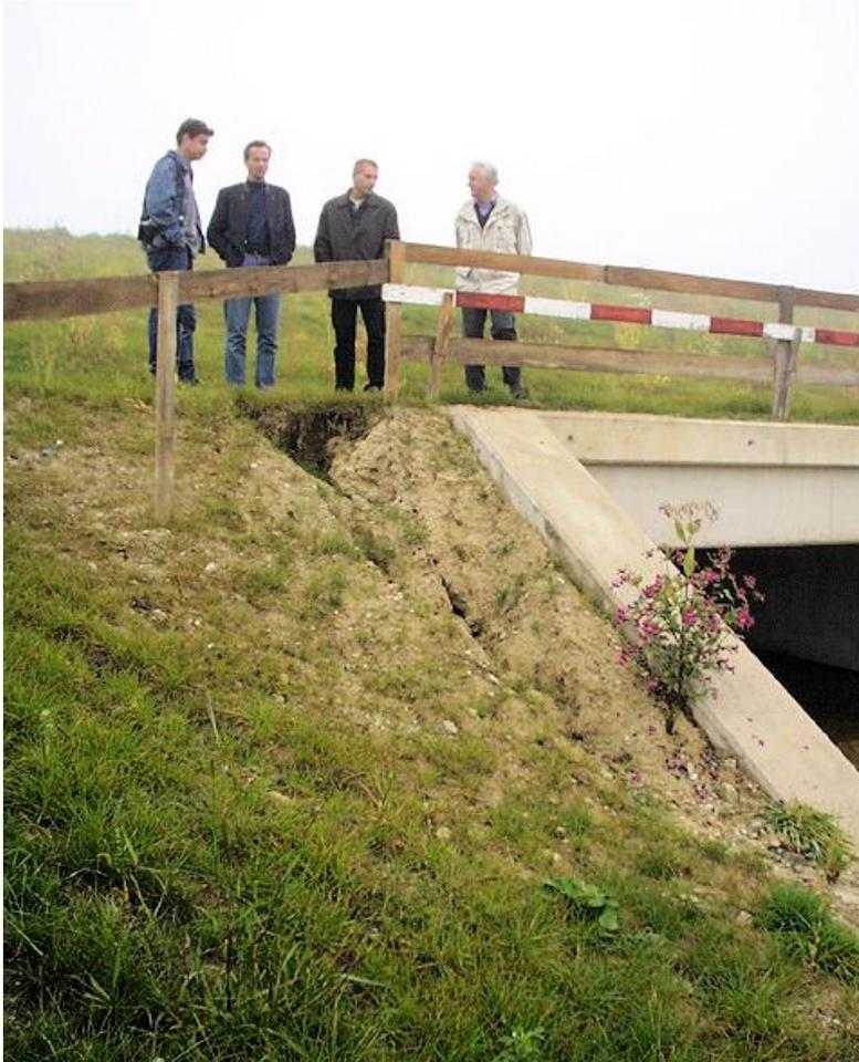
Durch fehlendes Böschungspflaster an der Flügelmauer wurde Material erodiert und somit der Damm geschwächt
