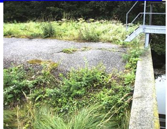
Entlang der Mauer wurde Material ausgetragen sodass sich die Dammkrone setzt
